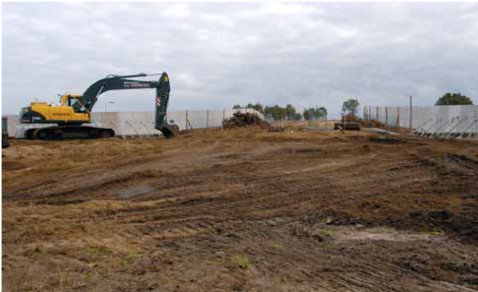
De afgelopen vijftien jaar zijn diverse natuurbruggen in Nederland aangelegd. De foto toont de bouw van 'De Borkeld' over de A1 bij Rijssen. Andere omvangrijke natuurbruggen zijn aangelegd over de A50 op de Veluwe: 'Terlet' en 'Woeste Hoeve' (zie de foto aan het begin van dit hoofdstuk). De natuurbruggen 'Boerskotten' en 'Harm van de Veen' liggen over de A1 bij Kootwijk (Foto: Roel Hoeve).
