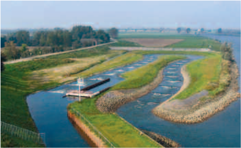
Ook het ministerie van V&W investeert in soortgerichte maatregelen. Een voorbeeld is het aanleggen van vispassages, zoals hier bij Hagestein (foto: Tom Buijse).
