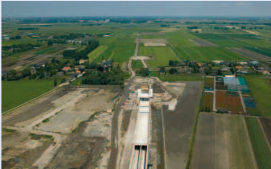
De aanleg van de HSL-tunnel vordert gestaag (foto: De Jong Luchtfotografie).
