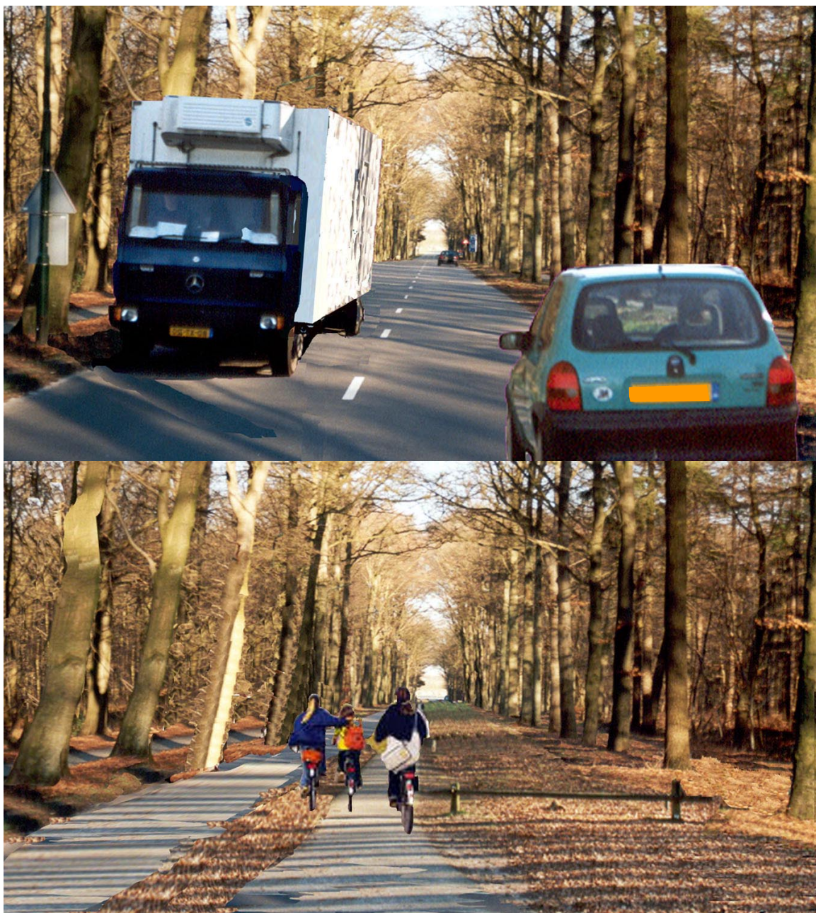
Figuur 2.1: Illustratie van een herprofilering van een ontsnipperde weg, voor- en nasituatie
