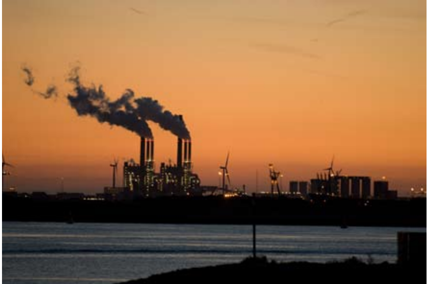
Elektriciteitscentrales langs de zee, zoals deze poederkoolgestookte centrale op de Maasvlakte, zijn minder kwetsbaar voor klimaatverandering. Windturbines en andere vormen van hernieuwbare energie dragen eveneens bij aan een klimaatbestendige elektriciteitsvoorziening. Foto: Nationale Beeldbank
