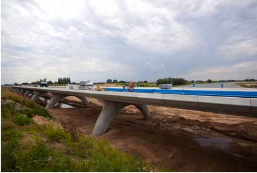
Bij Randwijk wordt een verhoogde weg aangelegd, zodat het omliggende gebied geschikt wordt voor berging van overtollig rivierwater.
