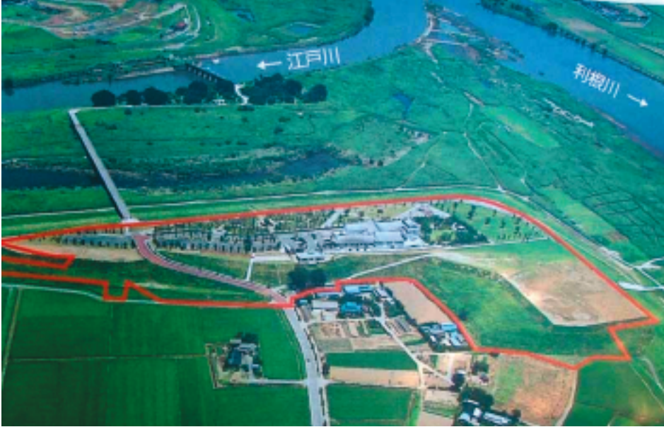
Extreem brede dijk (rood omlijnd) bij de splitsing van twee rivieren in Japan. Kenmerkend voor deze 'superdijk' is het flauwe binnenwaartse talud van 1:30. Hiermee wordt beoogd te voorkomen dat overslag en kwelwater de dijk verzwakt en een overstroming veroorzaakt. De dijk moet minimaal 3 uur overloop kunnen doorstaan om zo evacuatie mogelijk te maken.
