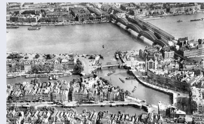
De spoorbrug over de Nieuwe Maas werd vervangen door een tunnel; enkele honderd meters oostwaarts kwam de vernieuwde Willemsbrug naar het Noordereiland.
