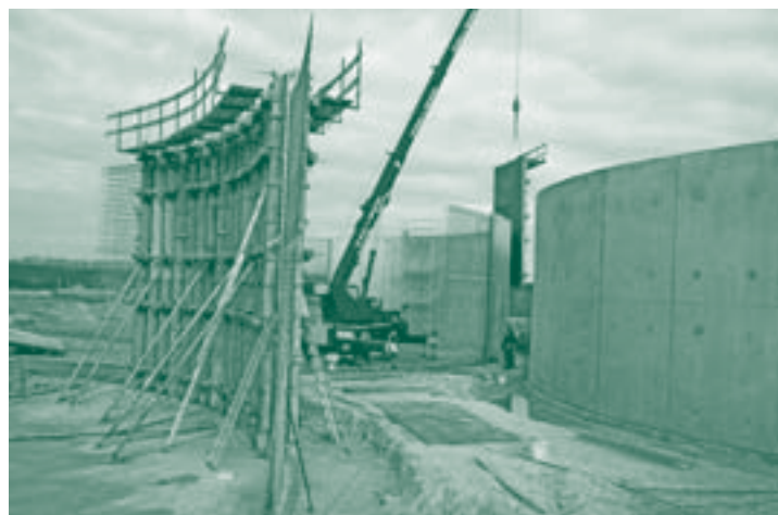
In Drenthe wordt momenteel gebouwd aan een geavanceerde mestvergister
