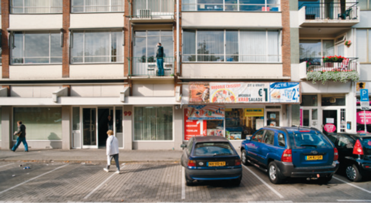
Steenstraat (oorspronkelijke locatie Eiffel, 1992-2000), Arnhem
