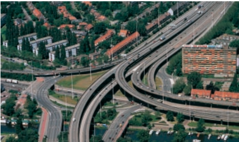
Milieu en economie in de leefomgeving: Rotterdam Overschie bij het Kleinpolderplein. (foto © www.fotopaulmartens.nl)
