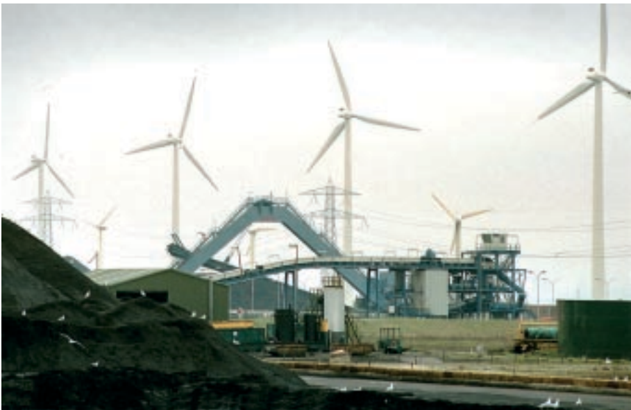
Energieproductie door kolen en wind, electriciteitscentrale EPZ te Vlissingen-Oost (Foto: D.J. Gjeltema).
