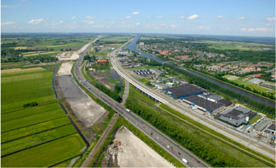
De voortdurende vraag naar ruimte voor verstedelijking in de Randstad kan een bedreiging vormen voor het open landschap, zoals hier de aanleg van de A2 bij Breukelen aan de rand van het Groene Hart.
