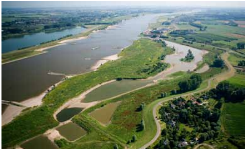
Een voorbeeld van een nationaal investeringsprogramma is het programma 'Ruimte voor de rivier'. Financiering door meerdere departementen wordt gecombineerd met de opbrengsten van bijvoorbeeld kleiwinning. Het resultaat is het verhogen van de waterveiligheid en de ontwikkeling van nieuwe natuur. Foto: De Jong Luchtfotografie.
