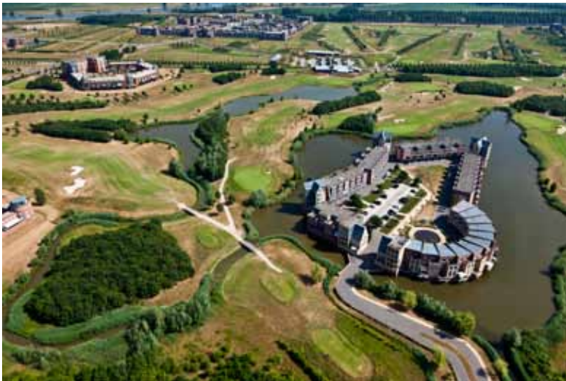
In het noordwesten van Den Bosch is het landgoedproject Haverleij ontwikkeld. Het totale plan omvat ongeveer 225 hectare, waarvan circa 20 hectare voor de kastelen en 65 hectare voor een golfbaan is gereserveerd. Het groen wordt vooral betaald uit de opbrengst van de woningen. Foto: Hollandse Hoogte/ Siebe Swart.
