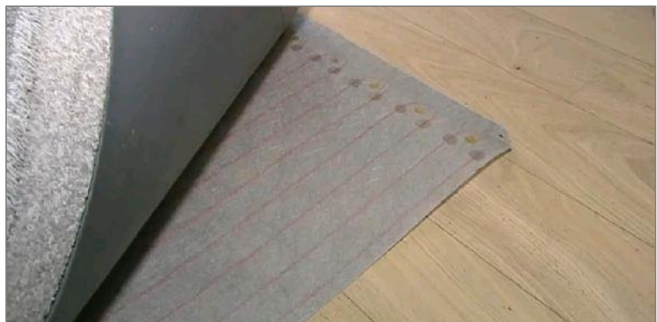
Figuur 21 Voorbeeld van elektrische weerstandsverwarming onder een vloerkleed
