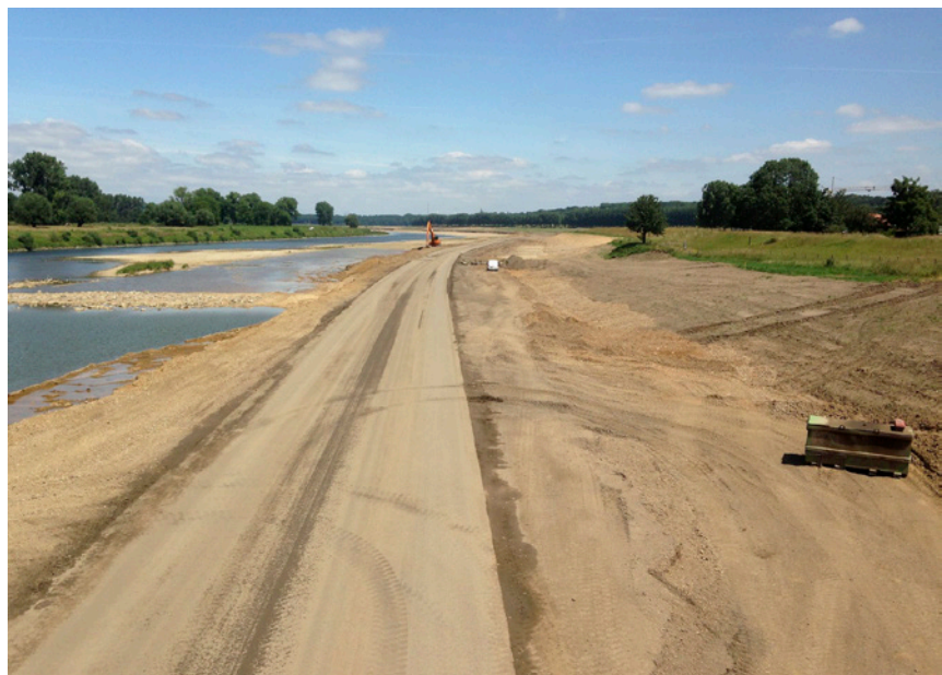
Werkzaamheden aan de Grensmaas
