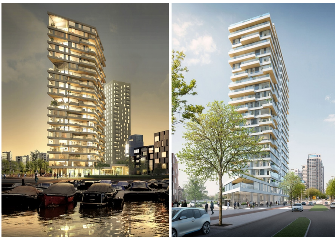
Figuur 6.1 Aan het IJ verrijst het HAUT-project: een houten woontoren van 73 meter en 21 verdiepingen bestaande uit 52 luxe woningen van 75 tot 326 m 2 . Op het dak komen 1250 m 2 zonnepanelen en een waterzuivering. Het gebruikte hout zal 3 kton CO 2 vastleggen. Het project is begroot op 25 tot 30 miljoen Euro.
