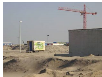
Bouw- en stortterrein
