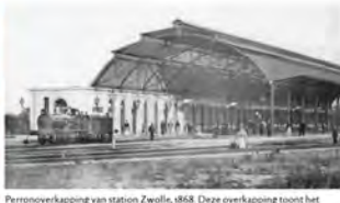
Perronoverkapping van station Zwolle, 1868. Deze overkapping toont het moderne gezicht van de negentiende eeuw: constructies volgens nieuwe technieken en uitgevoerd in nieuwe bouwmaterialen als ijzer en vanaf ongeveer 1870 op steeds grotere schaal steel. De overkapping was niet ontworpen in een historiserende stijl; de vormgeving werd bepaald door de constructie en het bouwmaterial.
