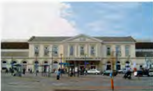
Station Zwolle, door Nicolaas Kampendijk, 1863-1868. Kampendijk ontwierp het stationsgebouw voor de Staatsspoorwegen in neoclassicistische stijl. Het treinstation als nieuw stadspoor, vormgegeven als de entree van een klassieke tempel.
