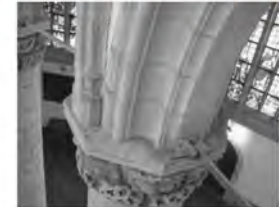
In tegenstelling tot de oerlijke bundelpijlers zonder kapiteel in de Dom van Utrecht, worden Hollandse stadkerken als die van Haarlem en Gouda gekenmerkt door zware zuilen en kapiteelen met grote dekplaten, die de speling geven tijdens de bouw.
