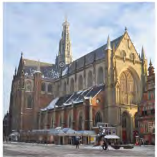
Grote of Sint-Bavokerk in Haarlem aan de Grote Markt. Aan de buitenkant is te zien dat de kerk deels is opgetrokken in natuursteen (grijs), deels in baksteen (bruin). De natuursteen is per schip aangevoerd uit groeven in de omgeving van Brussel, de baksteen is lokaal bouwmetaal.
