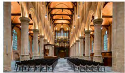
Interieur van de Nieuwe Kerk in Delft gezien naar het westen. De zuilen zijn uitgevoerd in grijze natuursteen uit groeven in de omgeving van Brussel, en dit geldt deels ook voor de spitsbogen in de arcade. De oranjepijler baksteen met het schip en de muren van de zijbeuken is een Hollands product. Schip en zijbeuken zijn gedekt in hout.
