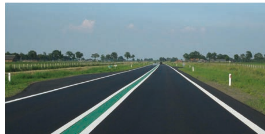
Een stroomweg die is ontworpen volgens de richtlijn van de Duurzaam Veilig wegategorisering
