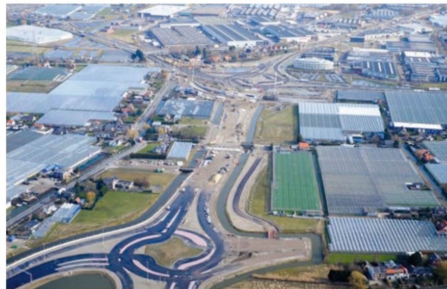
Intensieve bestuurlijke samenwerking is nodig voor de goede ruimtelijke inpassing van complexe infrastructuur, zoals hier de turbotorondes van het Maastdijkplein en de Tweepleinenweg
