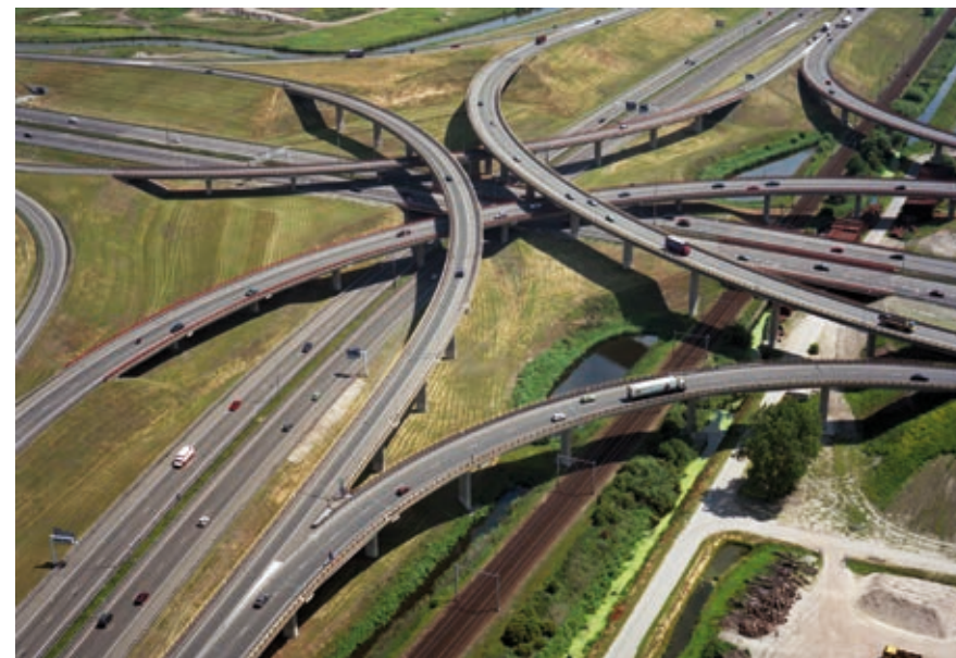
De ruime boogstralen van knooppunt Prins Clausplein bevorderen de doorstroming bij in- en uitvoegen
