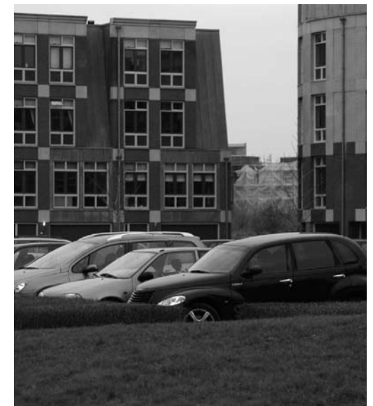
Figuur 53. Het binnenterrein van Zwaenenstede is in gebruik als parkeerterrein
