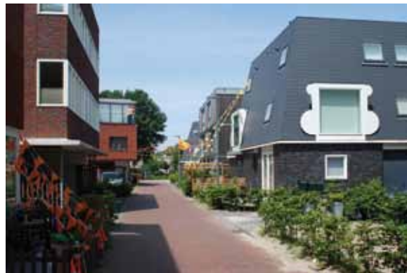
Compacte laagbouw op de locatie van een voormalig volkstuin-complex aan de rand van Amsterdam
